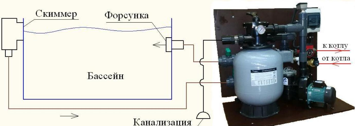
С помощь kleевой напорной ПВХ трубы диаметром 50мм., фитингов и клея от скиммера и от форсунки возврата воды, установленные в чашу бассейна, подводятся к стенду трубы, как показано на схеме. К третьему выходу фильтра подсоединяется труба диаметром 50мм. идущая в канализацию.
