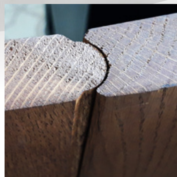
Стыковка досок «в паз» предотвращает их сколы и деформации
